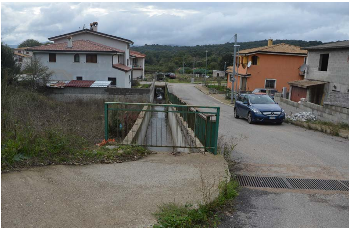
Foto n° 8 – Vista canalone verso via Monte Olinie
