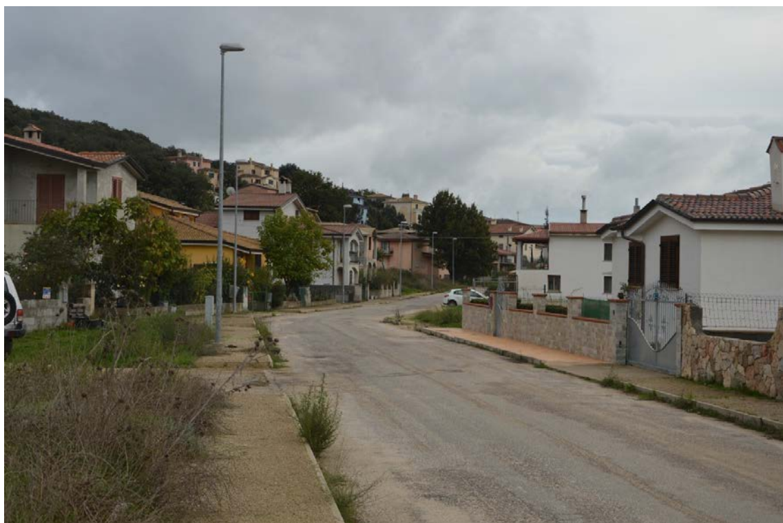
Foto n° 14 – Vista Via Monte Olinie 2° Tratto
