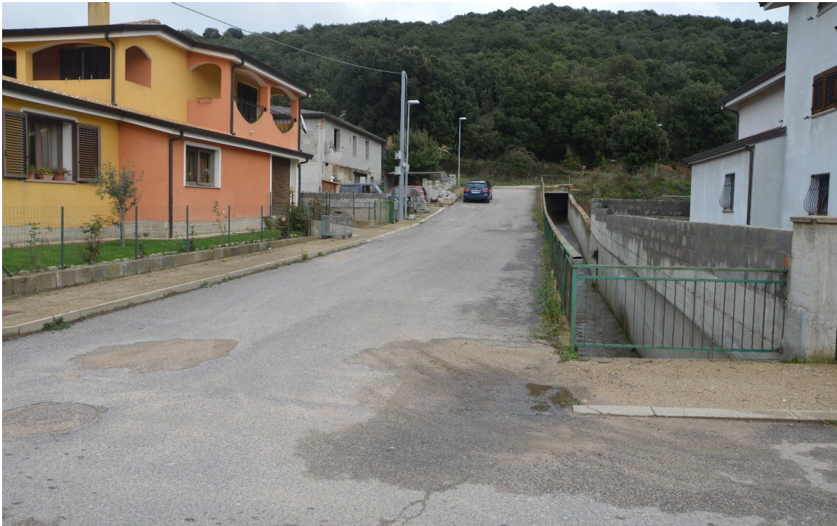
Foto n° 9 – Vista canalone verso Via Monte Predarba
