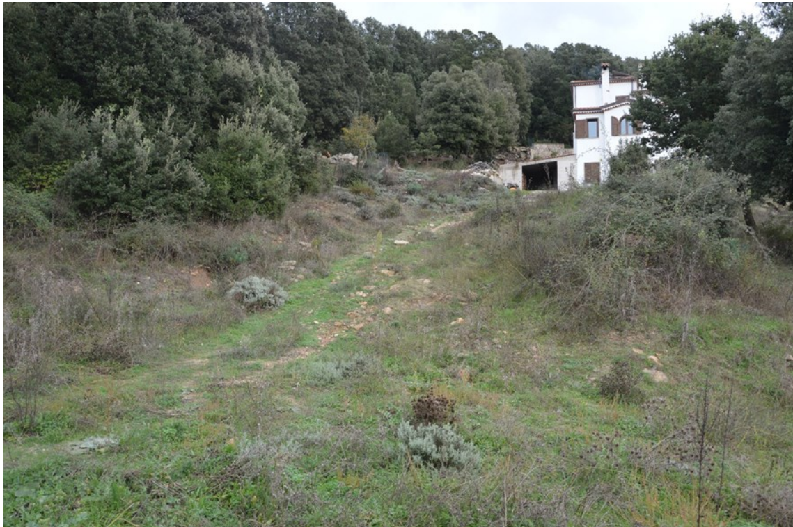
Foto n° 7 – Vista diramazione via Monte Predarba
