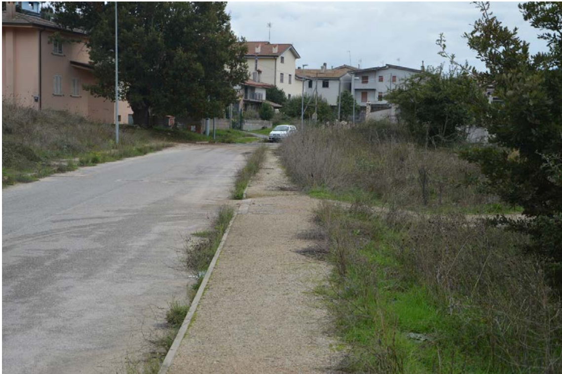
Foto n° 11 – Vista Via Monte Olinie 1° Tratto
