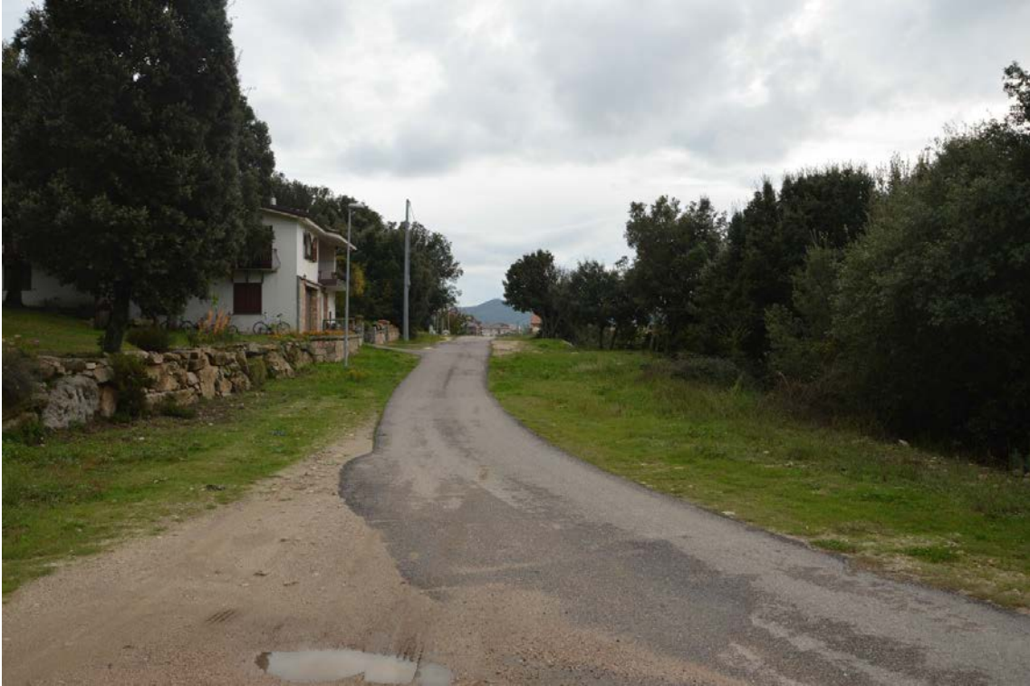
Foto n° 1 – Vista da Via Monte Predarba 1° Tratto
