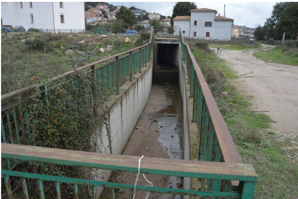
Foto n° 12 – Vista canalone in Via Monte Sa Mela
