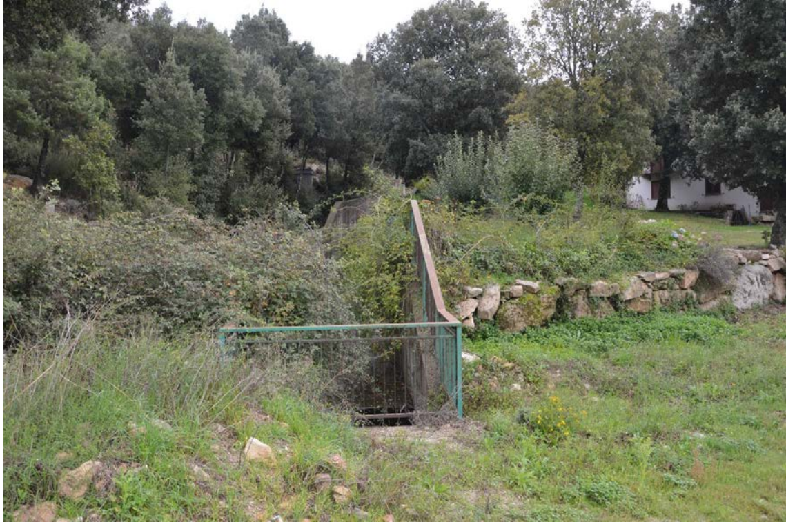
Foto n° 3 – Vista particolare canalone di scolo
