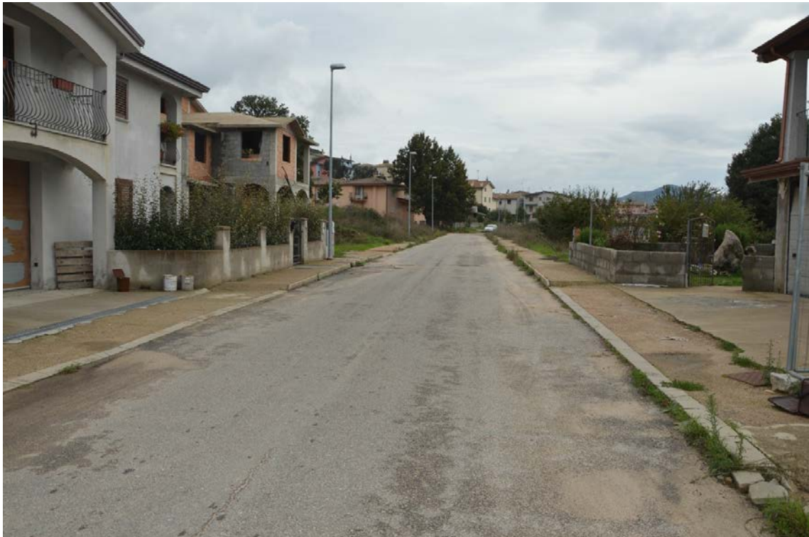
Foto n° 10 – Vista Via Monte Olinie 1° Tratto
